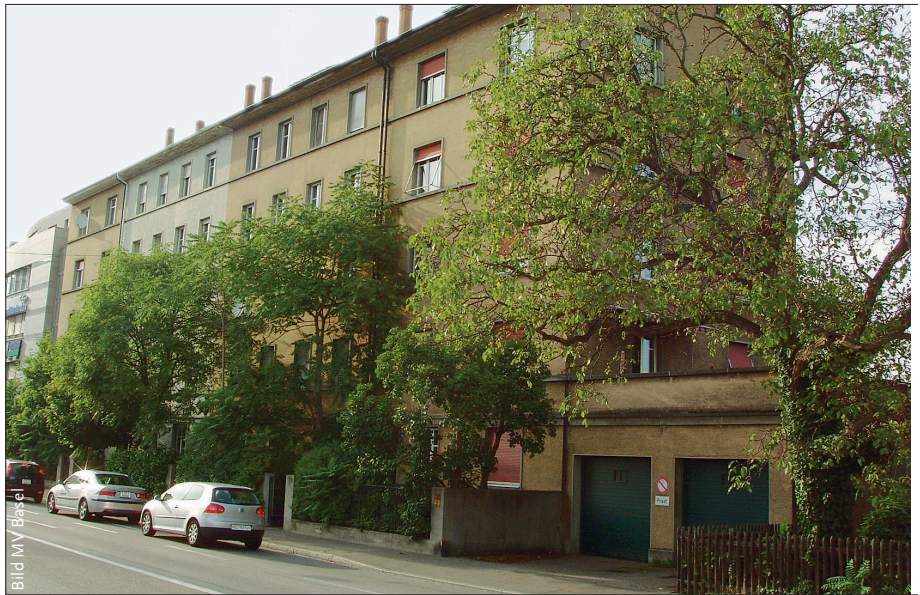
Abbruch steht bevor: Wohnhäuser an der Brüglingerstrasse
