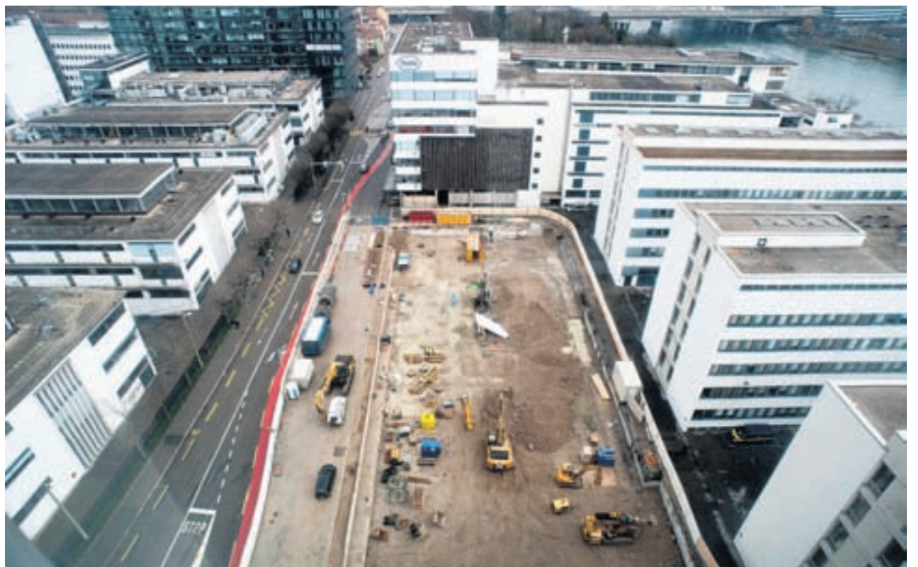
Areal an der Grenzacherstrasse. Die Baumaschinen stehen schon für den Aushub bereit. Fotos Roland Schmid
