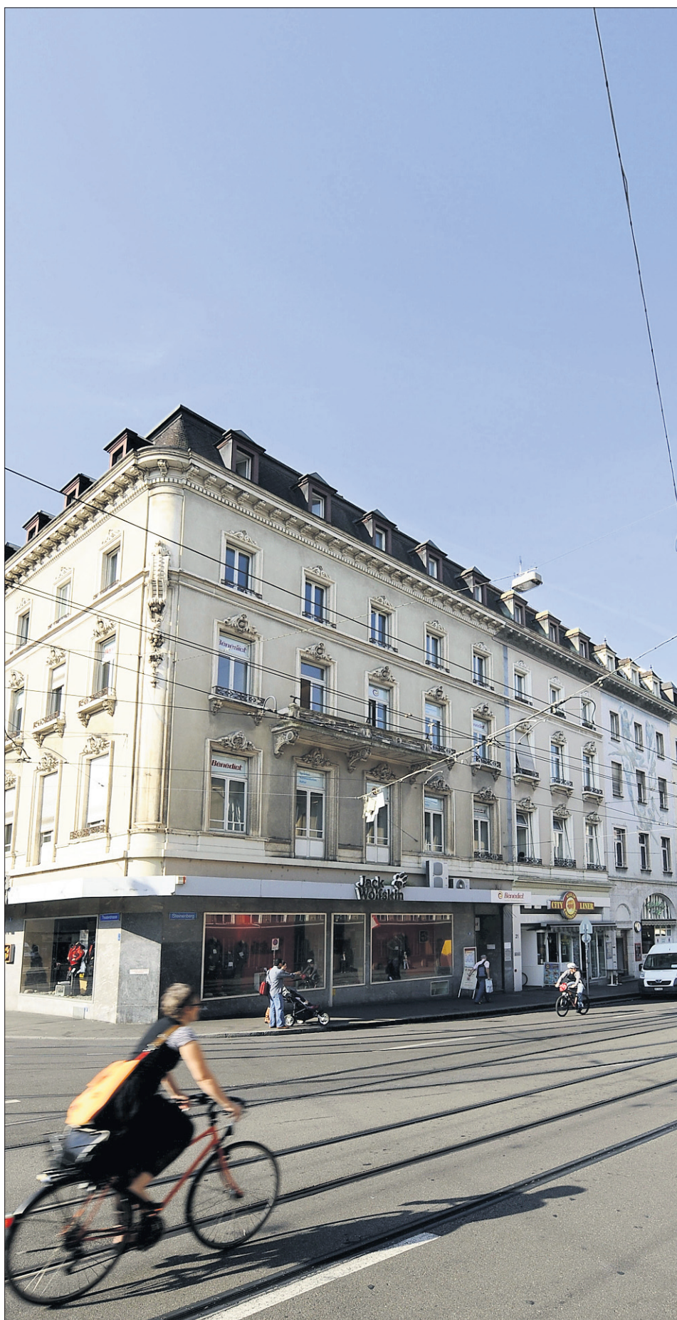
ENSEMBLE Die drei Häuser am Steinenberg bilden ein Ensemble. Vier Organisationen wollen es erhalten, die Besitzerin plant eine Totalsanierung. KENNETH NARS
