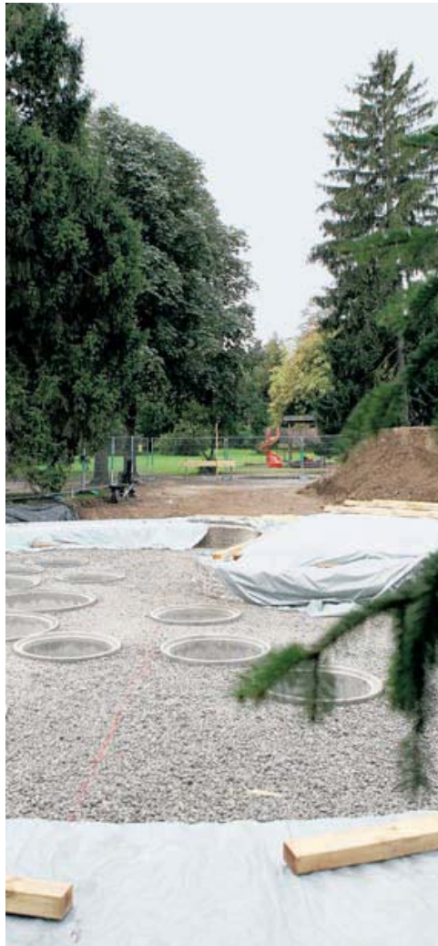
Versenkt. Betonfundamente im Kannenfeldpark für die Holzstämmen, die der Schaukel- und Rutschinsel als Grundgerüst dienen. Foto Henry Muehnerberger
